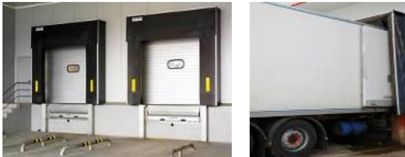
Muelle de carga con túneles isotérmicos
